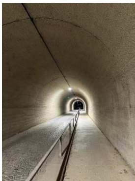
Figura 4 – Infraestrutura urbana em Deggendorf.
