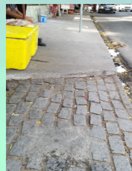
Figura 7 – Acesso principal – (Situação D)
