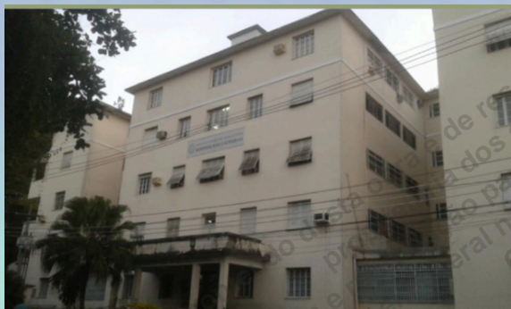
Figura 2 – Fachada do Hospital São Zacharias antes da reforma de 2020
