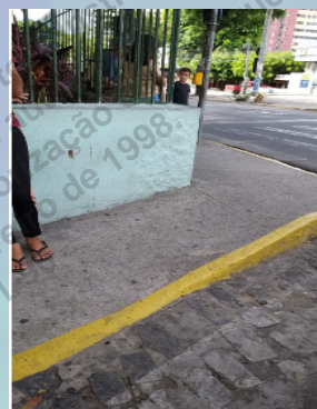
Figura 6 – Acesso principal – (Situação C)
