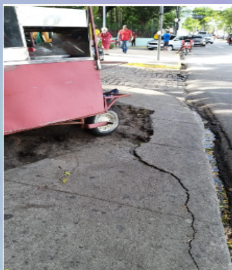
Figura 3 – Acesso principal – (Situação A)
