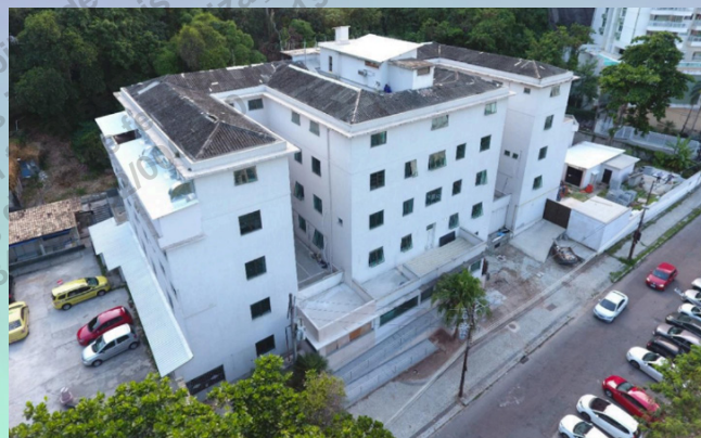
Figura 3 – Projeto de reforma: Orion Arquitetura - 2018 a 2023
