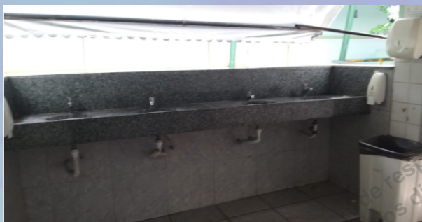
Figura 31 – Lavatório na circulação Fonte: Acervo Pesquisa
