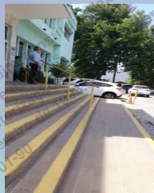
Figura 9 – Acesso principal - escada Fonte: Acervo Pesquisa
