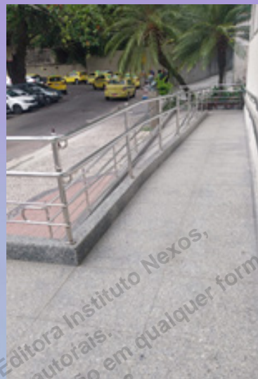
Figura 10 – Patamar da rampa de acesso Fonte: Acervo da Orion Arquitetura
